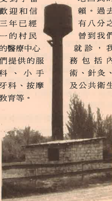
協助馬山清鎮整修水塔。
